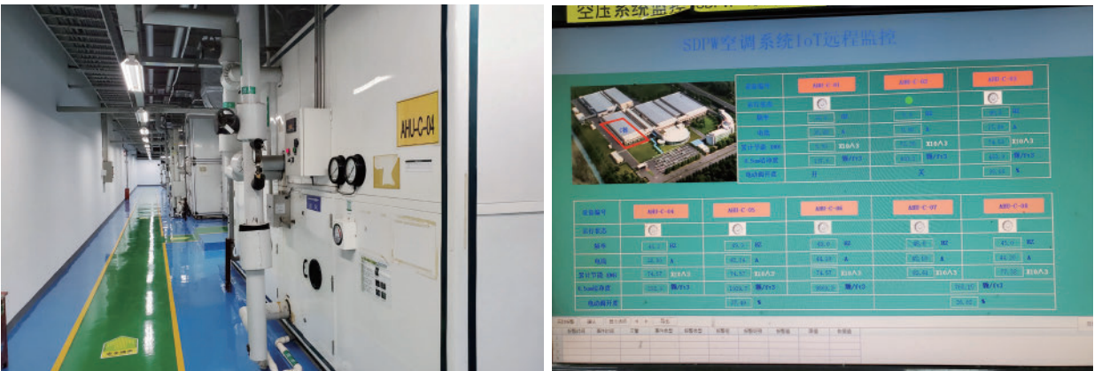
运用IoT技术，在洁净室负荷较低的状况下系统自动识别并调整组合式空调机的运转频率的事例
